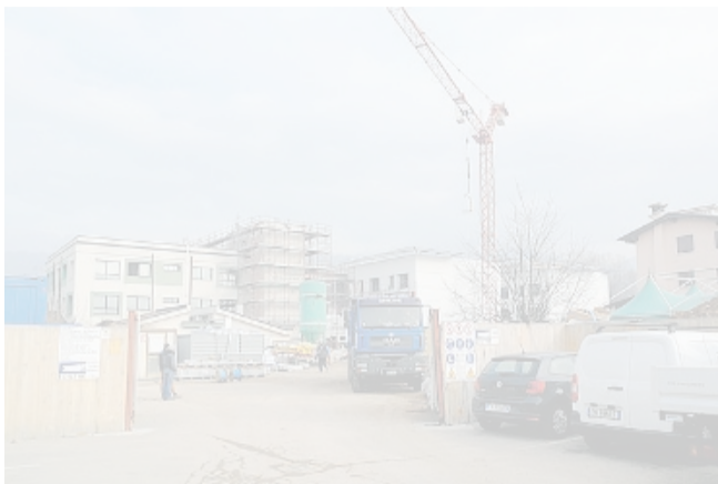
Verso quota 600mila. Non si fermano i cantieri alla Nikolajewka
